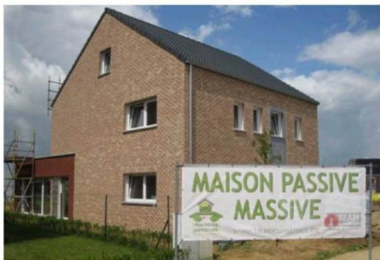
Passief huis van Team Construct © Team Construct
