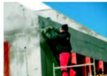
S.D. Le départ du chantier.
