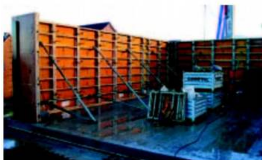
Ses murs de soutènement ont été coulés sur place.
