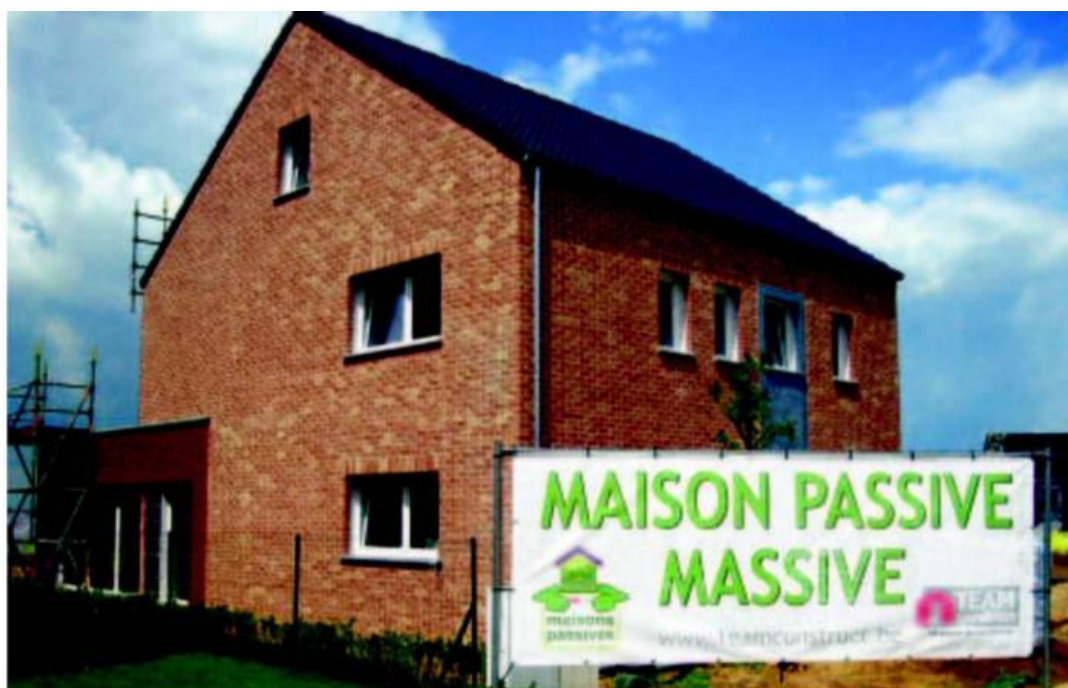
À Gembloux, la première maison en béton coulé certifiée passive de Belgique.
